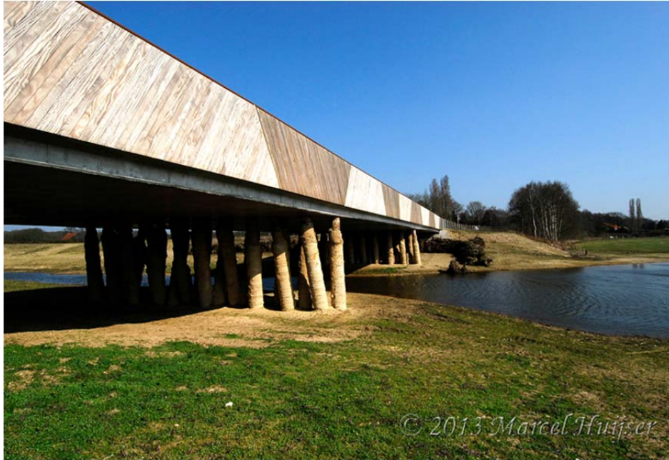
Figure 10: Overspan bridge with visual barriers, Rijksstraatweg Utrechtsestraatweg N225 just east of Elst, The Netherlands (© Marcel Huijser).
